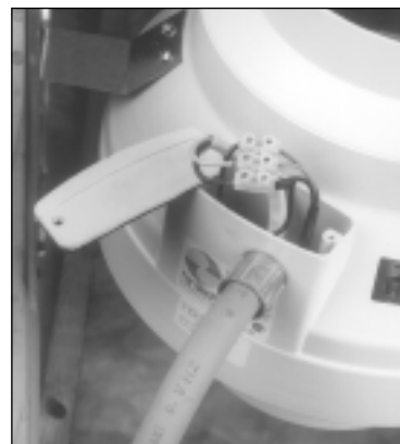
Vue du raccordement Romex
